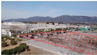
合成樹脂事業 関西オークラ新工場建設地【関西オークラ内(斜線部分)】
