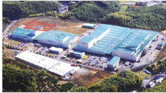
新規材料事業 新工場建設地【仲南工場内(斜線部分)】
