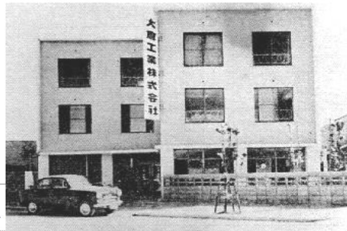
高松本社ビル
