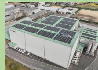
KSオークラ太陽光発電設備
