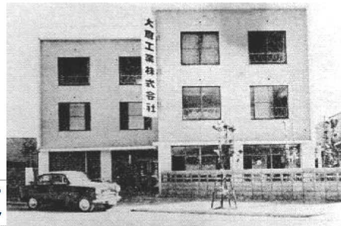
高松本社ビル
