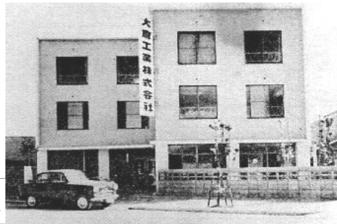
高松本社ビル
