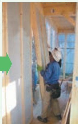
パネル入れ込み
