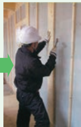
釘打ちでパネル留め
