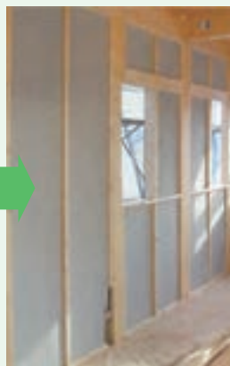
パネル入れ込み完了
